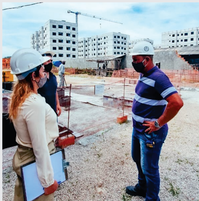
Cliente Leão Empreendimentos, obra Ville de Leon.
